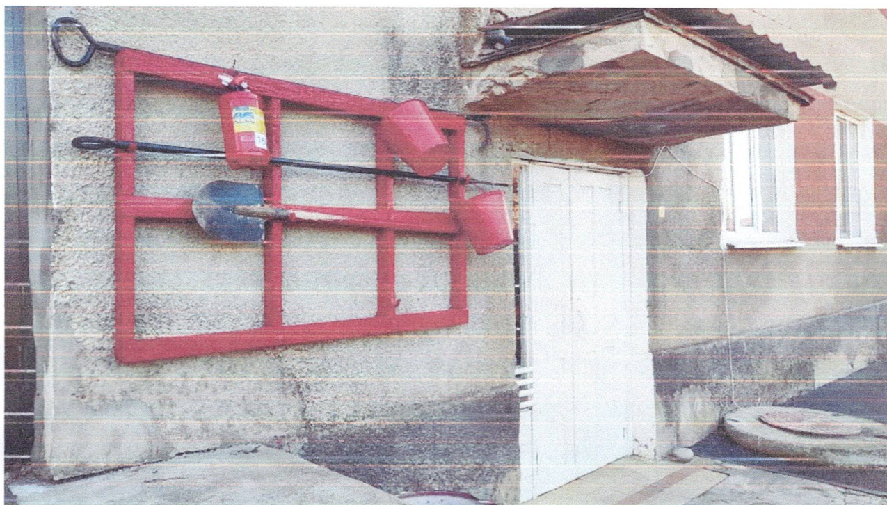
Фото 11. Вход в здание с задней стороны Дверь задняя.
